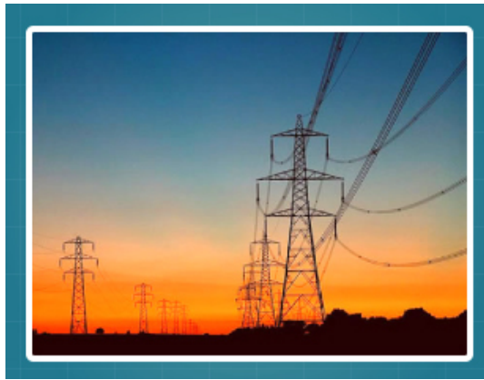
Figura 2 - Redes de distribuição de energia elétrica
